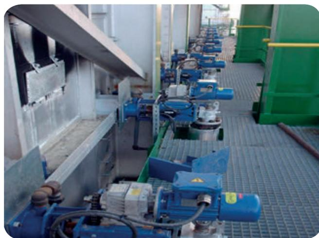
I soffiatori Clyde Bergemann parzialmente retrattili sono un'alternativa valida e più compatta ai soffiatori retrattili per applicazioni di medio-alto sporcamento, con temperature dei fumi che permettono una esposizione permanente delle lance all'interno del forno. Con un'azione combinata rotativa e assiale è possibile attraverso un movimento elicoidale ottenere un risultato comparabile a quello dei soffiatori retrattili.
