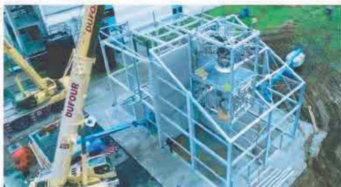
INSTALLAZIONE DEL MODULO DEL REATTORE DI IDROGENAZIONE NELL'EDIFICIO PROGETTATO DA EKATO
